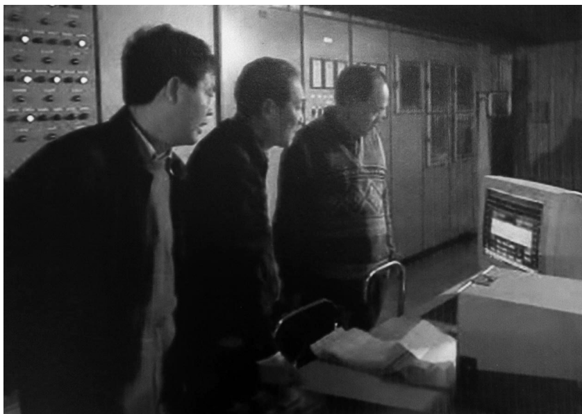
大型热连轧机生产线调试现场
