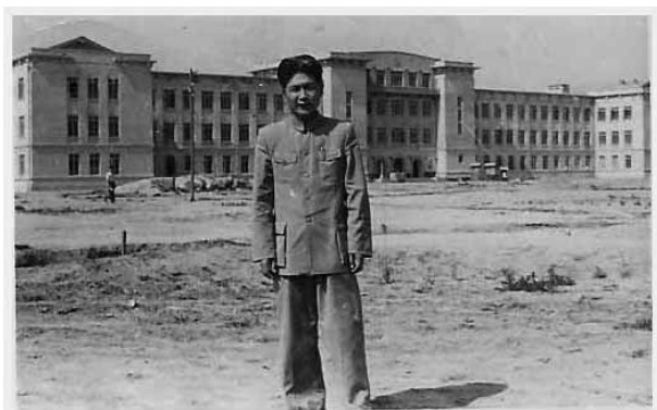
在理化楼工地上（1953年）
